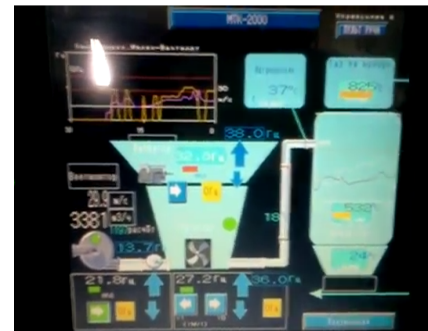
Лицевая панель щита управления
